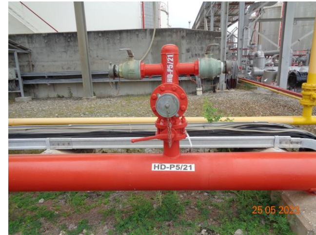
ภาพที่ 2.3-37 หัวจ่ายน้ำดับเพลิงทุกระยะ 40 เมตร
