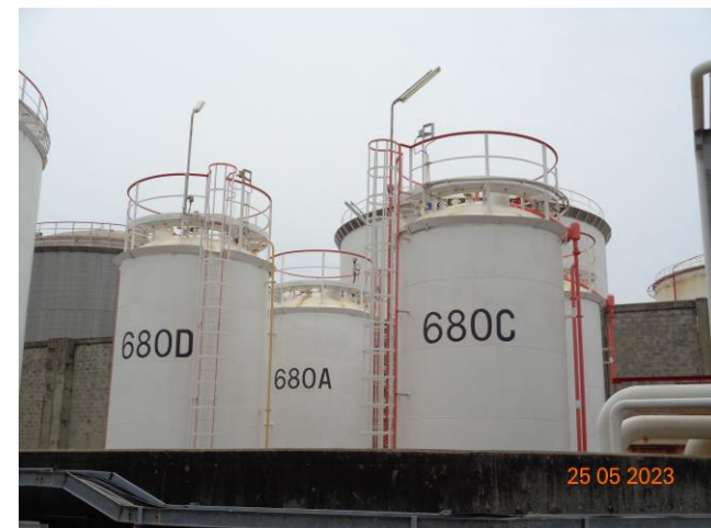
ภาพที่ 2.3-12 ถังรองรับน้ำอับเฉา
