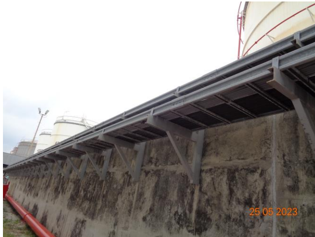
ภาพที่ 2.3-36 Bund Wall ของแต่ละกลุ่มถัง
