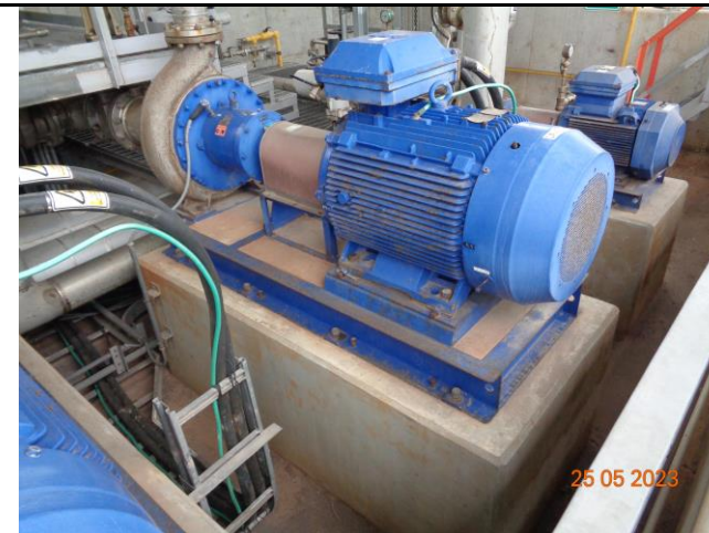
ภาพที่ 2.3-6 ฐานรองรับคอนกรีตเสริมเหล็กป้องกันการสั่นสะเทือน
