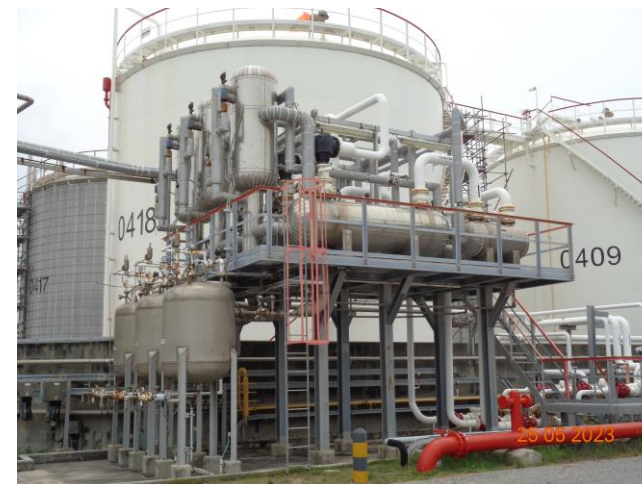
ภาพที่ 2.3-43 Vent Condensing Unit
