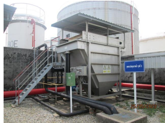
ภาพที่ 2.3-10 Oil-Water Separator
