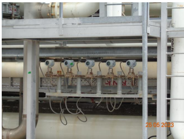
ภาพที่ 2.3-42 Pressure Transmitter
